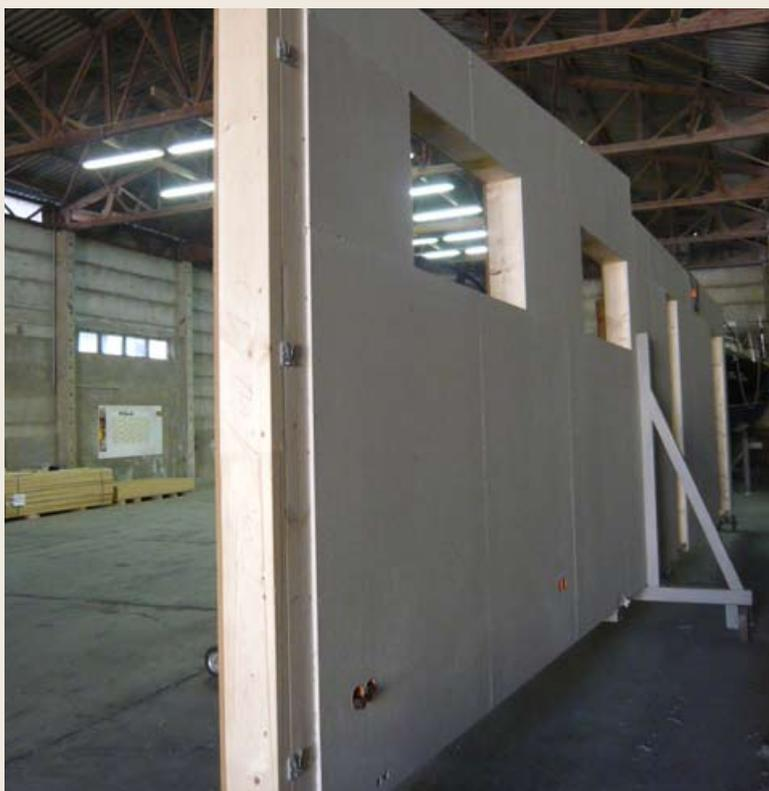
◀ An einem Rahmenstiel sind drei Walco-V-Verbinder aufgeschraubt. Nach dem Einhängen der anschließenden Wand stehen beide Wände automatisch exakt im rechten Winkel zueinander
