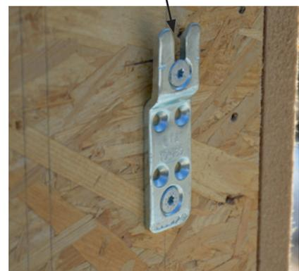
Der Walco 40 wird im Werk vormontiert und auf der Baustelle nur noch eingehängt
