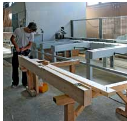
Ein Mitarbeiter von Tussa Haus montiert das Walco V-System, ohne zu messen, an den vorgebohrten Stellen
