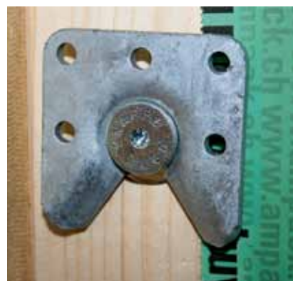
Die eingehängte Grundplatte gleicht bei Nadelholz Toleranzen von bis zu 2 mm aus
