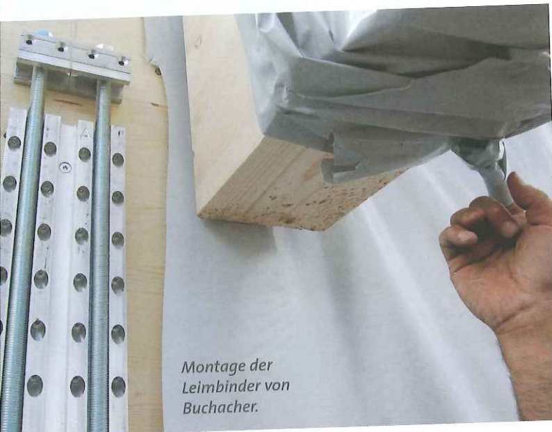
Nach dem Festziehen der Spannbacken mit den Gewindestangen wird die volle Tragfähigkeit erreicht und der Anschluss ist fugendicht.
