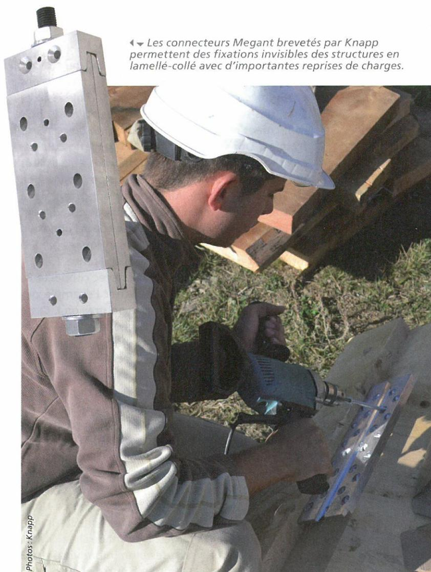
Les connecteurs Megant brevetés par Knapp permettent des fixations invisibles des structures en lamellé-collé avec d'importantes reprises de charges.
