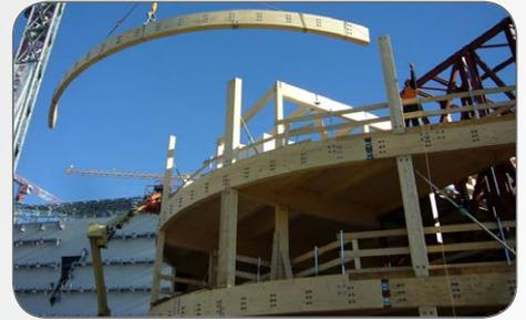
Der Pavillon mit seinen drei Stockwerken und einem 1500m<sup>2</sup> großen Gewölbe, größtenteils aus Holz, verfügt über 730 individuelle Trägereile. Er ist in seinem Inneren bis zu 8 Meter und teils bis zu 12 Meter hoch.
