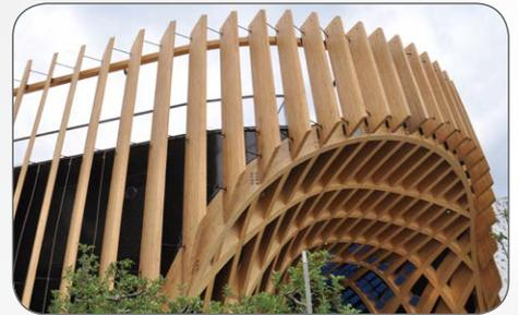
Ein Gitter aus gekrümmten BSH-Trägern mit einem Abstand von 1,5 Meter bildet die formvollendete Decke der „Markthalle“. Der planerische Wunsch waren Verbinder aus Stahl, die sowohl einen kurzem Einhängeweg wie auch die Wiedererlegbarkeit des Gebäudes ermöglichen.
