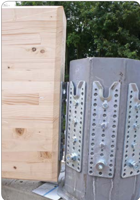
Ein polygonförmiger Stahlrohrabschnitt mit ringsum aufgeschraubten Trägerplatten der RICON® S-Verbinders schließt die Bögen im höchsten Punkt der Kuppel zusammen. Sie wurden einfach rundum eingehängt.
