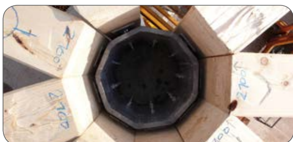
Ein polygonförmiger Stahlrohrabschnitt mit ringsum aufgeschraubten Trägerplatten der RICON® S-Verbinders schließt die Bögen im höchsten Punkt der Kuppel zusammen. Sie wurden einfach rundum eingehängt.
