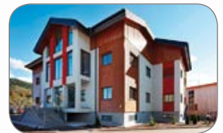
Bürogebäude StoraEnso (A)
