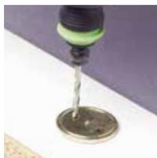
2) Mit Körner Bohrpositionen übertragen und Ø = 5 mm
