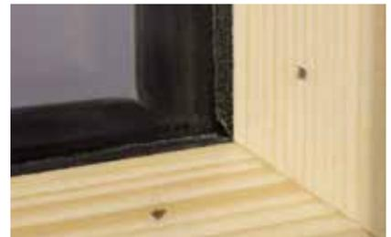
Herkömmlich befestigte Glasleiste mit sichtbaren Nägeln.
