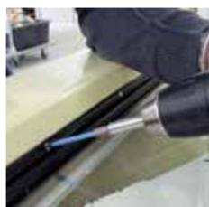
2) FIXclip-Schiene verschrauben
