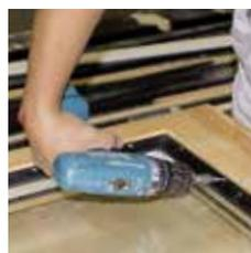
3) FIXclip-Schiene verschrauben oder nageln
