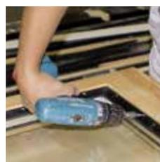
3) FIXclip-Schiene verschrauben oder nageln
