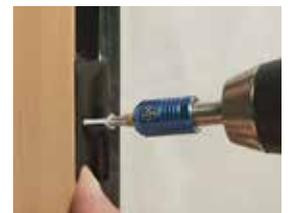
Anpressdruck durch 45° Schrägverschraubung
