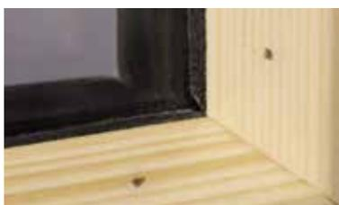
Herkömmlich befestigte Glasleiste mit sichtbaren Nägeln.
