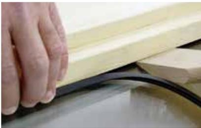
Anpressdruck über die Keildichtung
