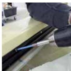
2) FIXclip-Schiene verschrauben
