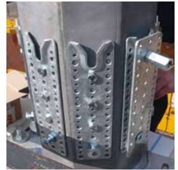
Firstknoten für Kuppeldach
