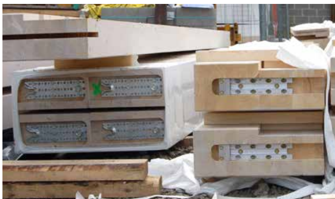
RICON® S dreiseitig im Nebenträger eingefräst
