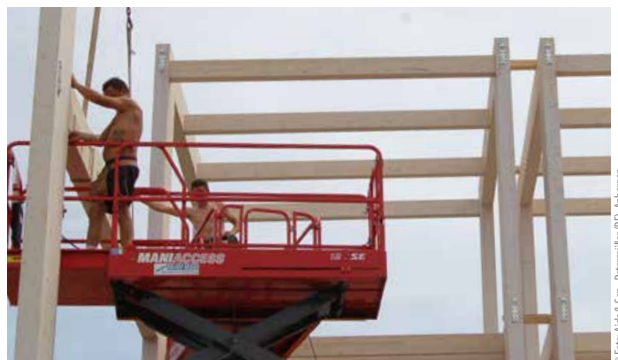
Einbau des Nebenträgers mit Stütze mittels RICON®S
