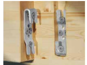
Montagebeispiel: Verschraubung an Haupt- und Nebenträger.
