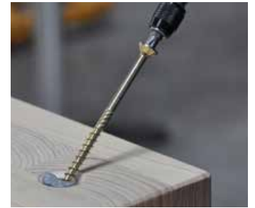
❹ T-JOINT 20 Schrägverschraubung mit einer SK-Schraube Ø 6mm schließen.
