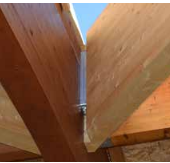
Assemblage en angle MEGANT®
