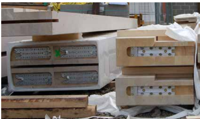
RICON® S encastré en bout de poutre secondaire, non visible sur 3 côtés
