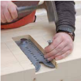
2) Positionnement des ferrures et vis
