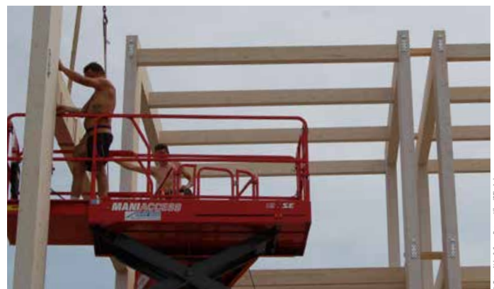
Montage d'une structure poteaux - poutres avec RICON®S
