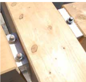
Assemblage poutres principale et secondaires en face à face avec MEGANT® en applique.
