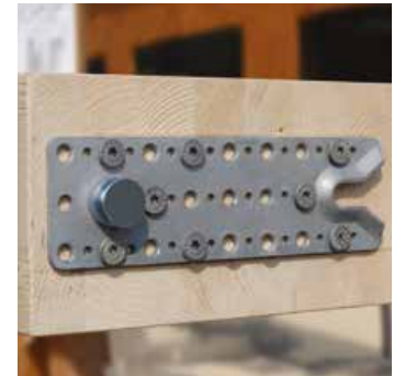
4) Vissage sur la poutre secondaire
