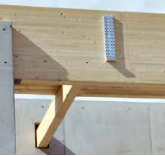
Montage avec emboîtement dans réservation en béton - distance d'accroche seulement 2 cm.
