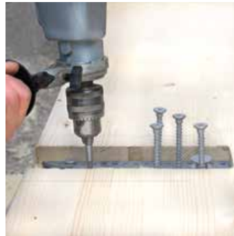
3) Vissage sur la poutre principale
