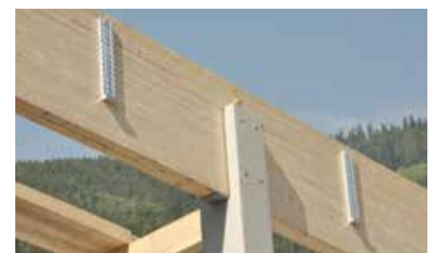
Exemple de montage MEGANT® vissé en applique : Pas d'affaiblissement de la poutre principale.
