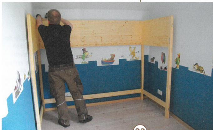
23 > Im nächsten Schritt hängen Sie die untere Strebe zwischen die beiden Rahmen, es folgt das breite Seitenbrett. So kann man fast ohne fremde Hilfe das Bett aufbauen.
