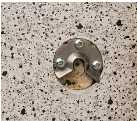
Im Türen- und Fensterbau kommt unter anderem der Einhängerverbinder Uno 30 zum Einsatz, der Scherkräfte bis 150 kg aufnehmen kann.
