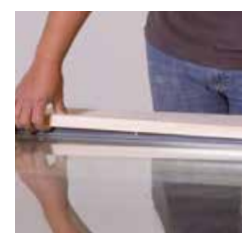
4) Clipser la parclose sur FIXclip-Barre
