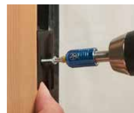
Pression d'appui grâce au vissage biais à 15°
