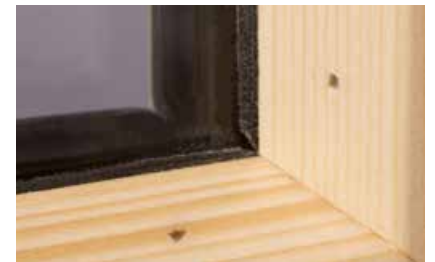
Fixation traditionnelle de parclose par clouage.
