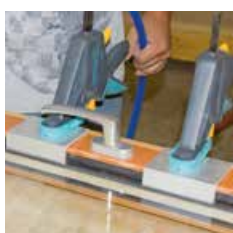
2) Presser la vitre contre les joints extérieurs
