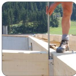
**13:23** | Insertion des tiges filetées et vissage dans la mâchoire basse.
