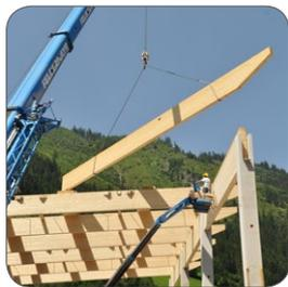
**13:16** | Démarrage du levage de la poutre lamellée et présentation pour l'accroche sur MEGANT®.
