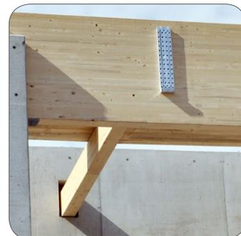
Montage avec emboîtement dans réservation en béton - distance d'accroche seulement 2 cm.
