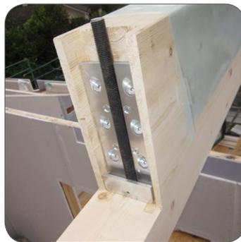
Montage encastré sur 3 côtés avec usinage en bout de panne et fixation de la plaque principale en applique sur le porteur.
