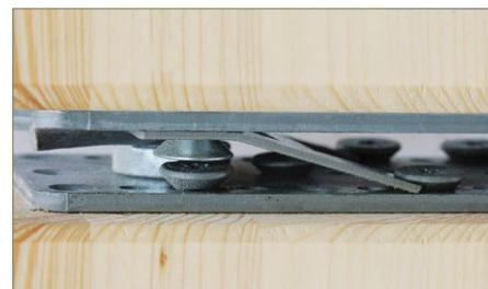
**Utilisation :** Bloque le système en sens contraire à l'emboîtement (par ex. lors de fortes dépressions causées par le vent)
