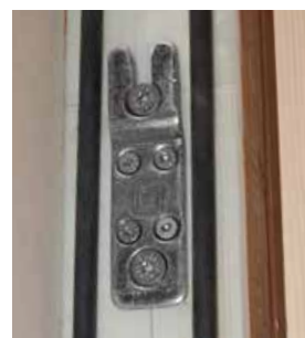
Exemple de mise œuvre : Ferrure sur mur ossature bois avec double joint.
