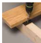
Verschrauben Lagerholz
