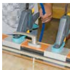
Scheibe gegen Außen-dichtung anpressen
