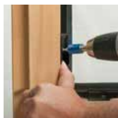
FIXclip GLE20 schräg verschrauben
