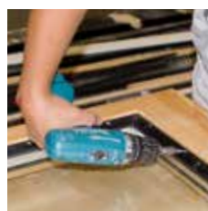
FIXclip-Schiene verschrauben oder nageln
