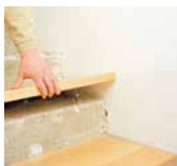
Bohrungen übertragen
