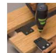
Vorbohren mit Schablone
