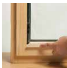
Einclipsen der Glasleiste
