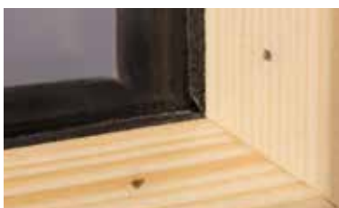
Herkömmlich befestigte Glasleiste mit sichtbaren Nägeln.
