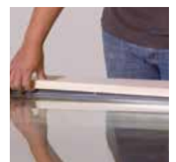
Einclipsen der Glasleiste
