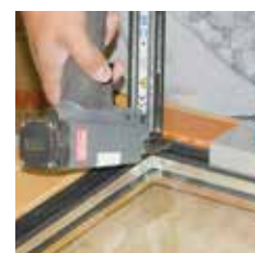
FIXclip-Schiene verschrauben oder nageln
