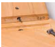
Spannelement in Bohrungen einlegen
