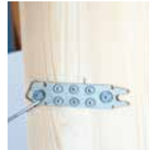
Sperrbügel montieren
