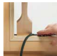
Keildichtung einpressen
