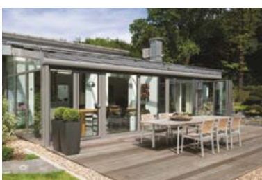
Construction de jardin d'hiver
