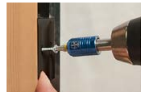
Vissage avec vis inox tête fraisée KNAPP®3,5x25 mm
