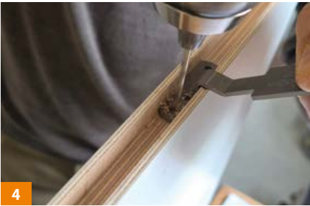
4 Bohrungen anhand der Bohrschablone ausführen.
