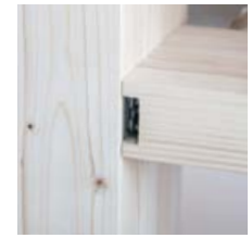
Gesicherte Verbindung durch Sperrbügel
