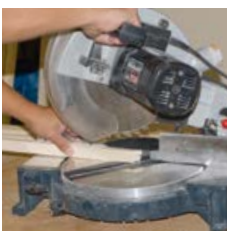
Glasleiste und FIXclip-Schiene zuschneiden
