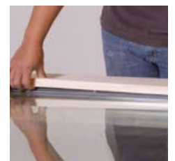
Einclipsen der Glasleiste
