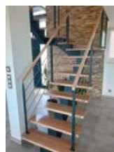
Aufgesattelte Stufen mit Acro befestigt
