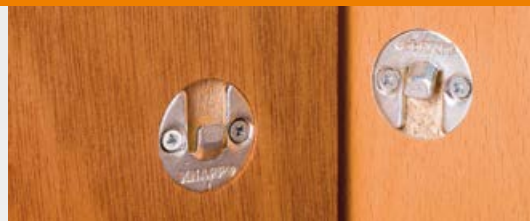
Montage an Vorsatzschalen, Aufdopplungen, Türblenden und Wetterschenkel.
