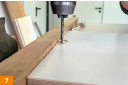
7 Löcher für Schulterkopfschrauben bohren.
