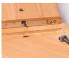
Spannelement in Bohrungen einlegen
