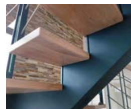
Aufgesattelte Stufen mit Acro befestigt
