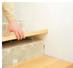
Bohrungen übertragen
