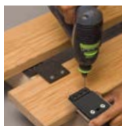
Vorbohren mit Schablone
