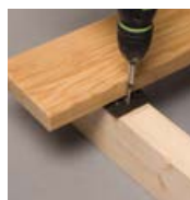
Verschrauben Lagerholz
