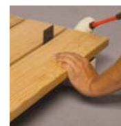
Abschlussdielen montieren
