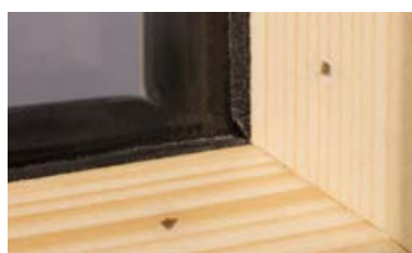
Fixation traditionnelle de parcloze par clouage.
