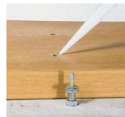
Encoller et monter
