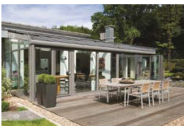
Construction de jardin d'hiver
