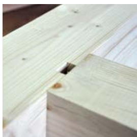
Jonction sécurisée avec goupille de verrouillage
