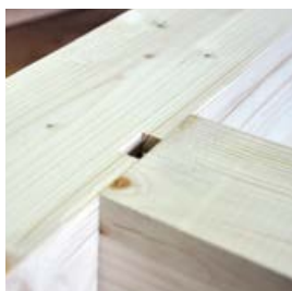
Gesicherte Verbindung durch Sperrbügel
