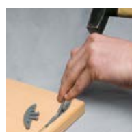
Mit Einschlagwerkzeug in Position bringen
