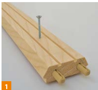
1 Blockleiste positionieren und verschrauben.
