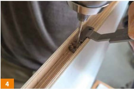
4 Bohrungen anhand der Bohrschablone ausführen.
