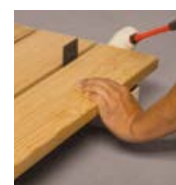
Abschlussdiele montieren
