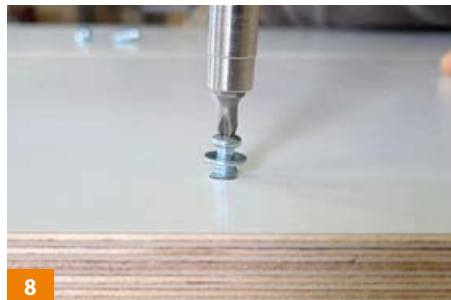
8 Schulterkopfschrauben einschrauben.
