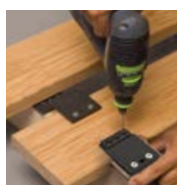
Vorbohren mit Schablone
