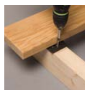
Verschrauben Lagerholz
