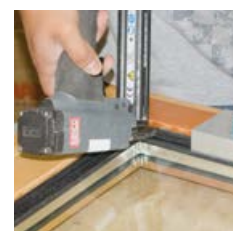
FIXclip-Schiene verschrauben oder nageln
