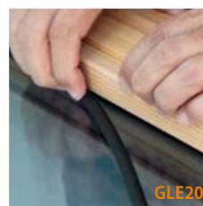
Keildichtung einpressen
