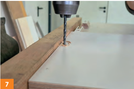
7 Löcher für Schulterkopfschrauben bohren.
