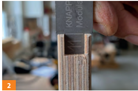
2 Kontrolle mit der Prüfschablone.
