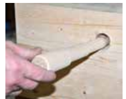
Einsetzen bis zum Nagelkopf.
