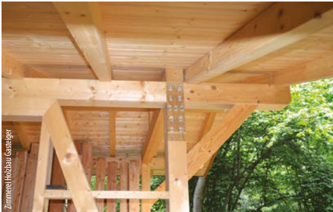
T-JOINT D35/W30 befestigte Laubholzlaschen von BSH-Zugstößen.
