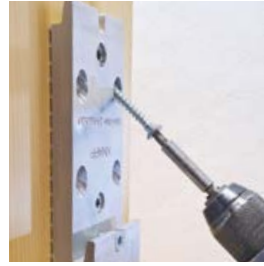
3. Die zweite Platte auf den Nebenträger schrauben.
