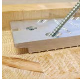
2. Horizontalschrauben einschrauben, dann Schräg- schrauben einschrauben.
