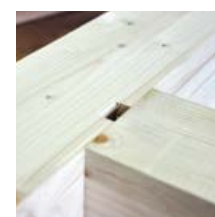
Gesicherte Verbindung durch Sperrbügel
