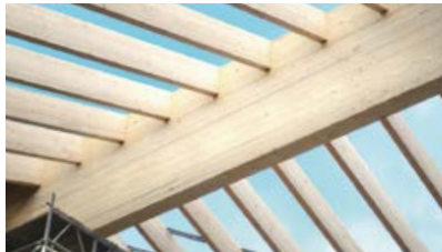
Hallendach mit RICON® S Firstanschluss
