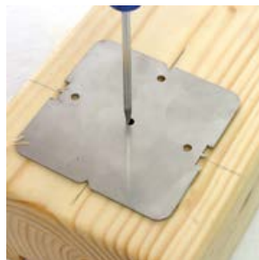
Falls erforderlich Ausfräsung herstellen, Bohrungen anzeichnen.
