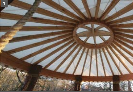
Schräganschlüsse Sparren an der Kuppel verschraubt mit T-JOINT.
