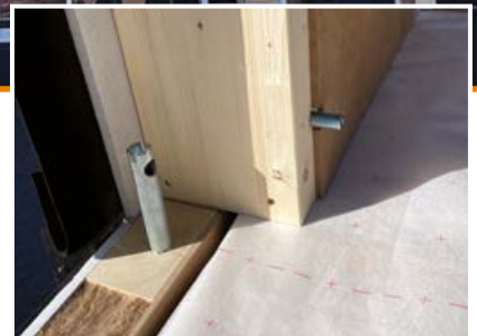
Detail: WALCO® PIPE Wand-Wand Verbindung
