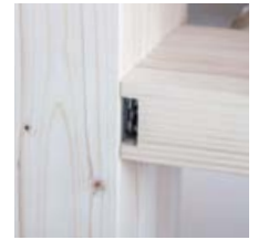
Gesicherte Verbindung durch Sperrbügel
