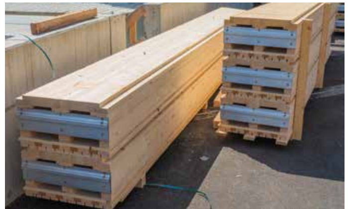
Der zweite Teil des Verbinders wurde in der Vorfertigung an den Stirnseiten der Brettsperrholzelemente befestigt.
