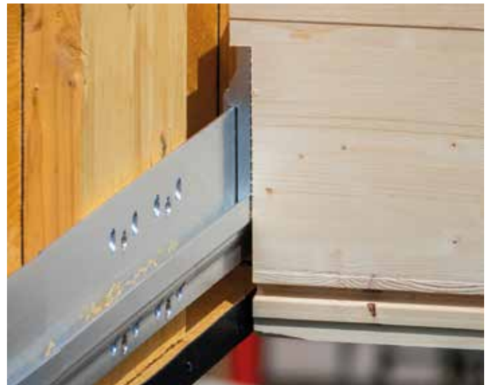
Der erste Teil des Verbinders wurde seitlich an den Satteldachbindern befestigt.
