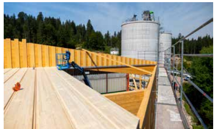
Aufgrund der vormontierten Verbinder konnten die Elemente binnen kürzester Zeit auf der Baustelle eingehängt werden.
