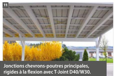
11 Jonctions chevrons-poutres principales, rigides à la flexion avec T-Joint D40/W30.
