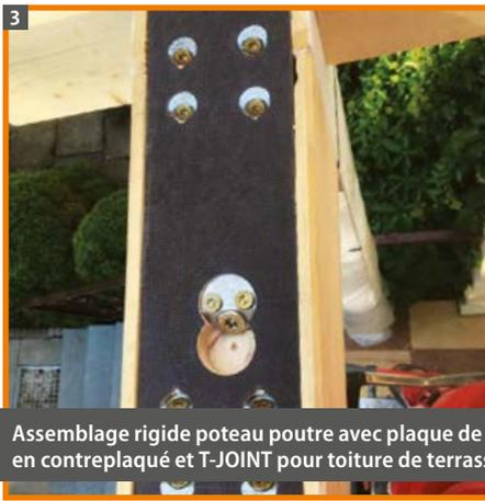
3 Assemblage rigide poteau poutre avec plaque de traction en contreplaqué et T-JOINT pour toiture de terrasse.
