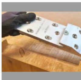
1 | Positionner la plaque EVO GRIP™ sur la poutre.
