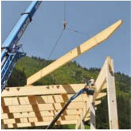
**13:00** | Démarrage du levage de la poutre lamellée et présentation pour l'accroche sur MEGANT®.
