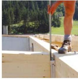
**13:08** | Insertion des tiges filetées et vissage dans la mâchoire basse.
