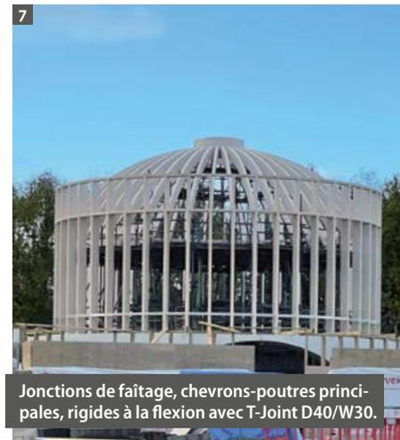
7 Jonctions de faitage, chevrons-poutres principales, rigides à la flexion avec T-Joint D40/W30.
