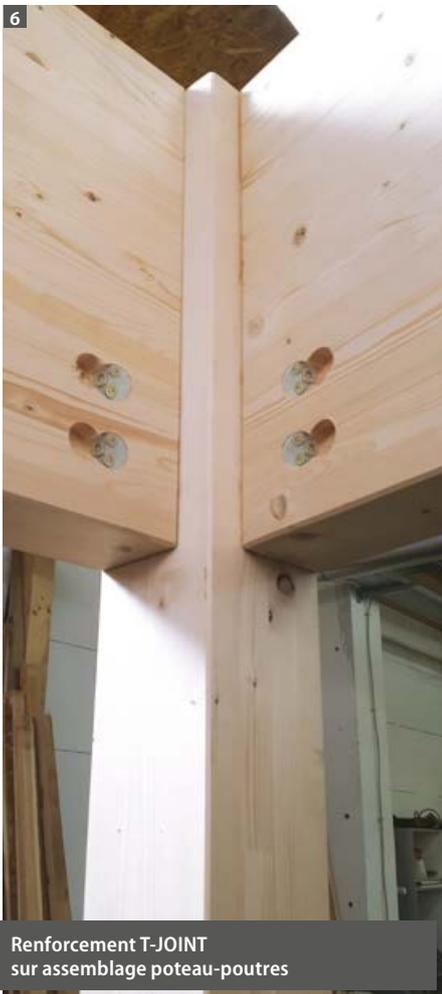
6 Renforcement T-JOINT sur assemblage poteau-poutres
