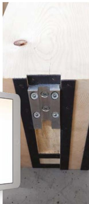
Des bandes de joint intumescent autocollant sont posées autour du connecteur et ensuite agrafées.
