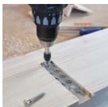
Pré-perçage et vissage
