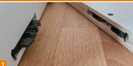
**1** Stoßverbindung (90°) mit Gewindestift sichern – auf 45° Gehrung mit oder ohne Verklebung zusammenstecken
