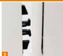
2 Verbinder positionieren (nicht versetzter Einbau!)
