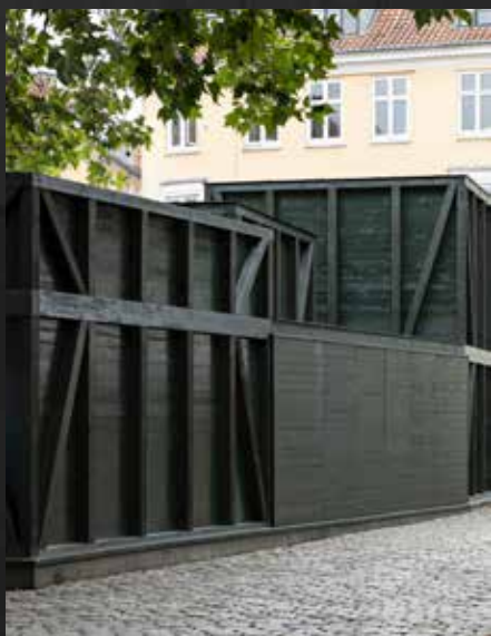
Der Pavillon Poetic Daylight wurde in kreislauffähiger Bauweise mit unsichtbaren RICON Verbindern errichtet. So konnte er von seinem Ursprungsstandort leicht umgezogen werden.
