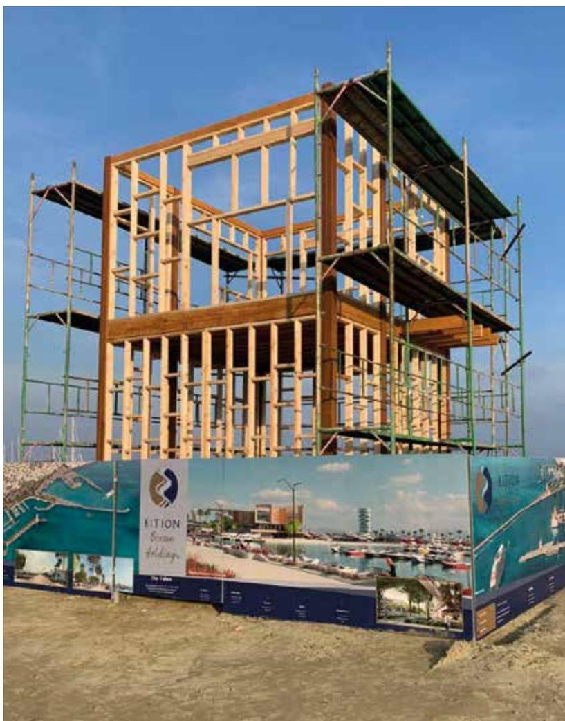
Das Rettungsschwimmer-Strandhaus zeigt einen weiteren Vorteil dieser Lösung auf: Sie lässt sich jederzeit zerlegen, sodass das Häuschen schnell abgebaut und an einer anderen Stelle dank Edelstahlverbindern wieder aufgestellt werden kann.
