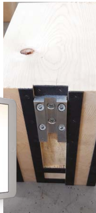
Das selbstklebende Brandschutzlaminat wird in Streifen rund um den Verbinder angeklebt und danach angeklammert.
