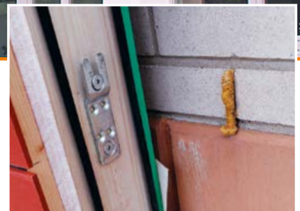
Montagebeispiel: Montiert an Wandelement mit beidseitigen Dichtungen.
