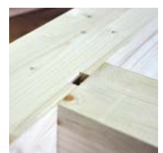
Gesicherte Verbindung durch Sperrbügel
