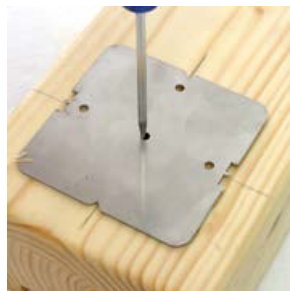
Falls erforderlich Ausfräsung herstellen, Bohrungen anzeichnen.
