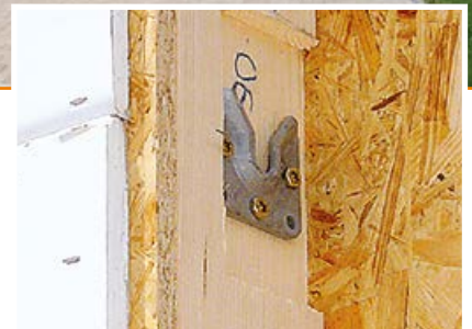
Montagebeispiel: Wandverbindung
