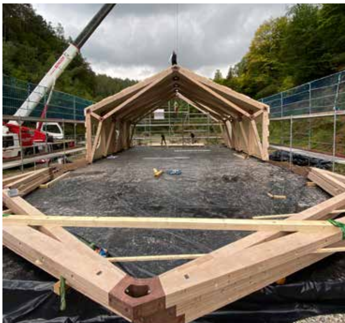
Die Dreigelenkrahmen werden gestellt.
