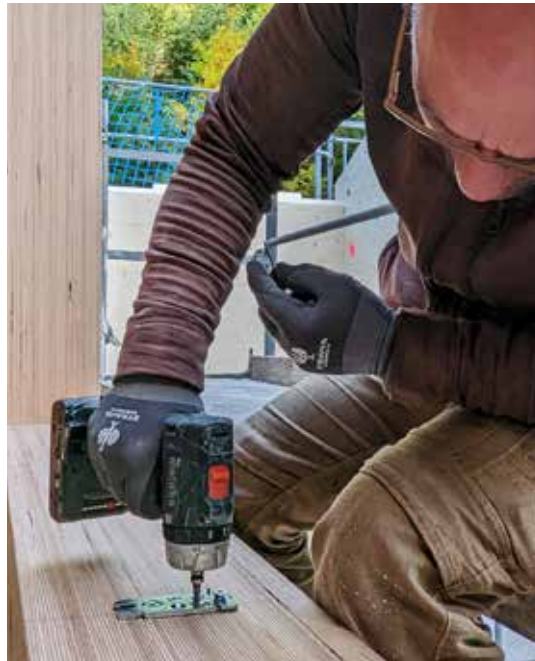
Verbindermontage im Werk und Finish der Pfosten-Riegel Fassade vor Ort.
