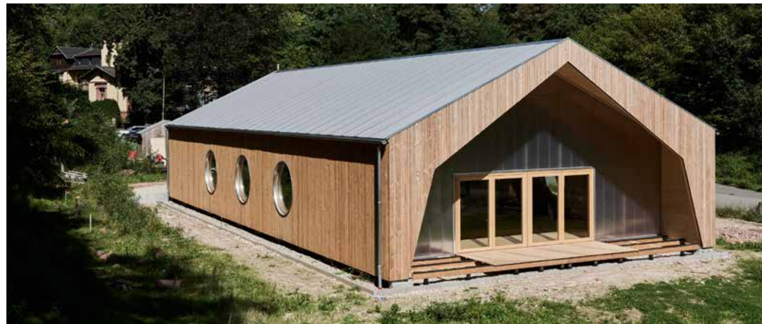
Selbst gebaut: Werk- und Forschungshalle
