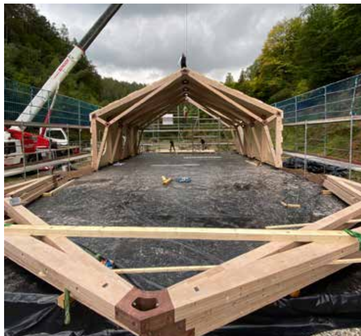
Die Dreigelenkrahmen werden gestellt.
