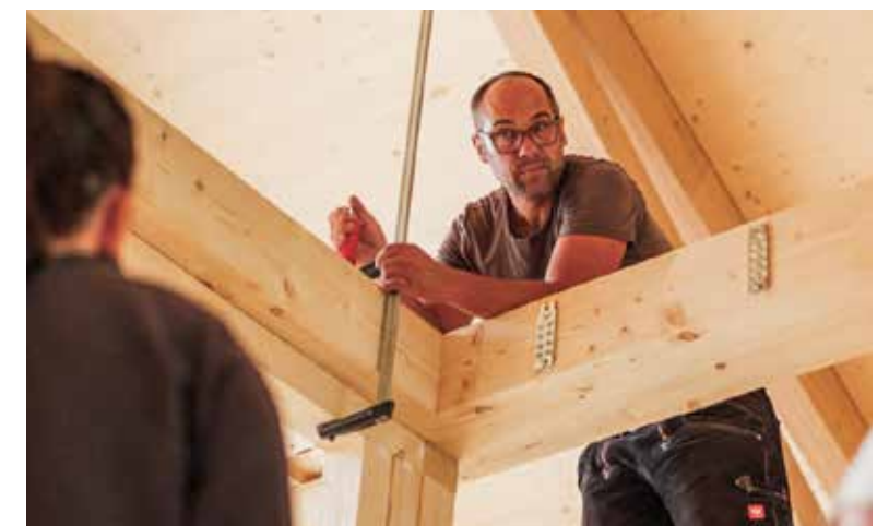
Der Verbinder wird montiert und im Anschluss eingehängt.
