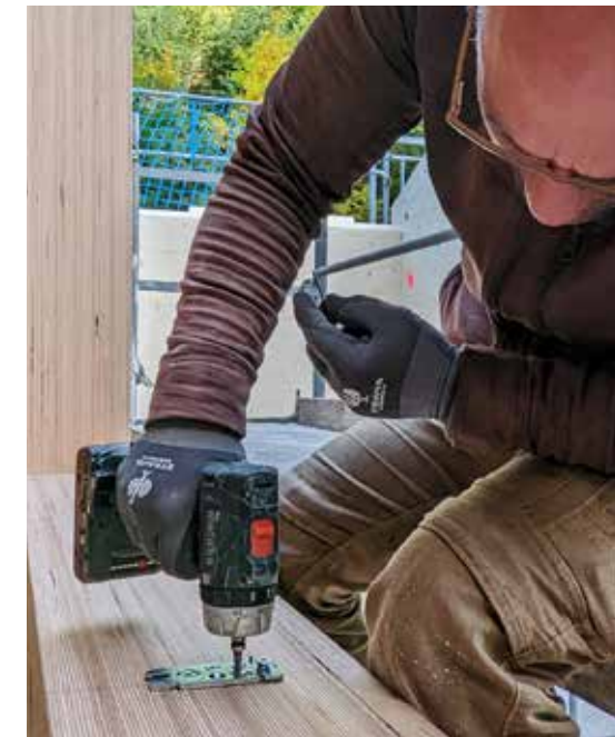
Verbindermontate im Werk und Finish der Pfosten-Riegel Fassade vor Ort.
