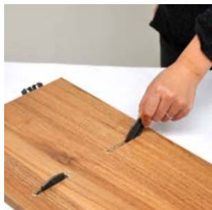
Verbinder flächenbündig einstecken.
