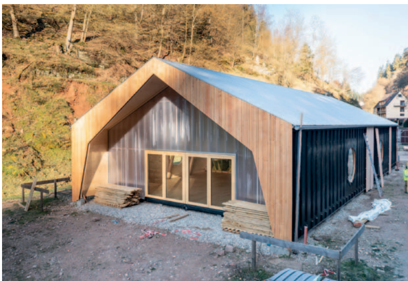
▲ So gut wie fertig: die Forschungs- und Werkhalle Diemerstein
