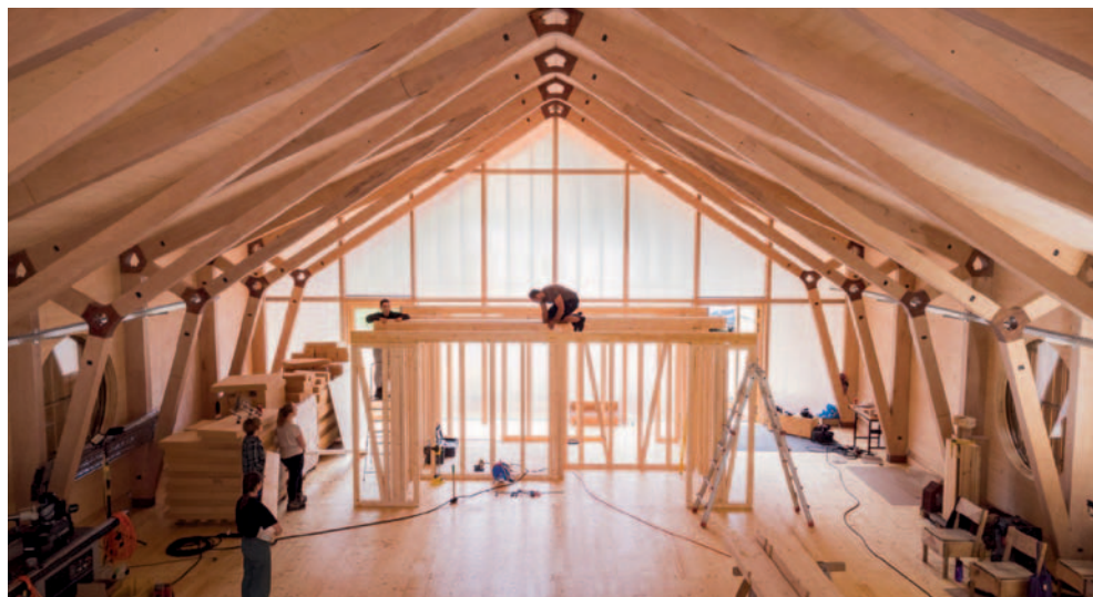
▲ Die Halle ist fertig aufgestellt. Der Innenausbau hat begonnen
