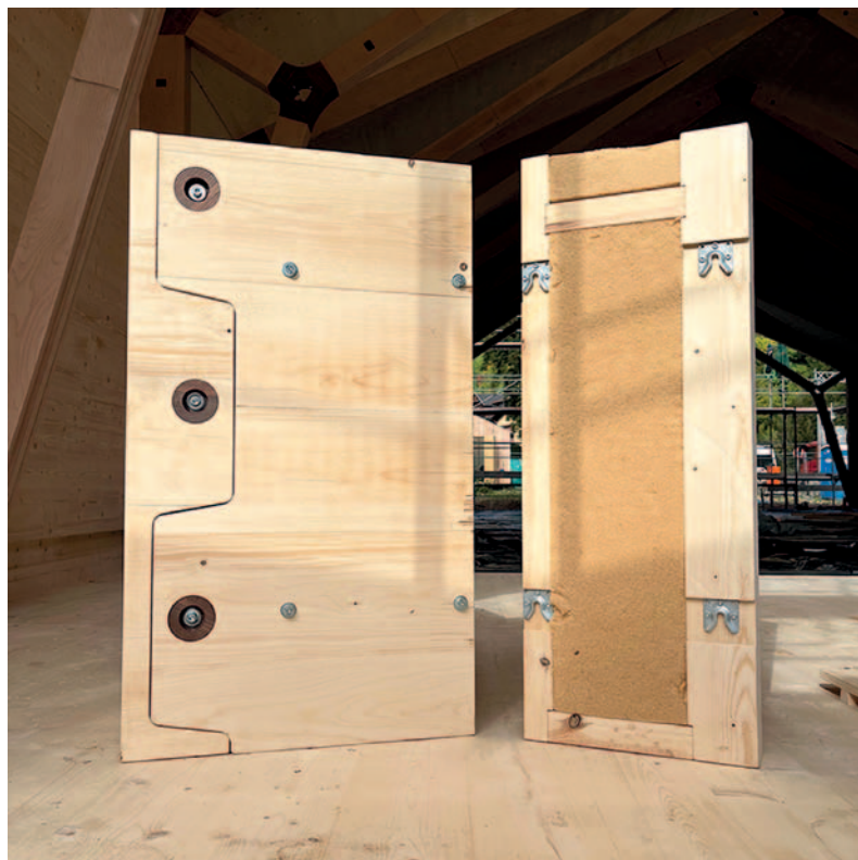
◀ Das Fassadenmodell zeigt kreislauffähige Befestigungsmittel für nachhaltigen Holzbau: links die Konosadapter, rechts Knapp-Verbinder
