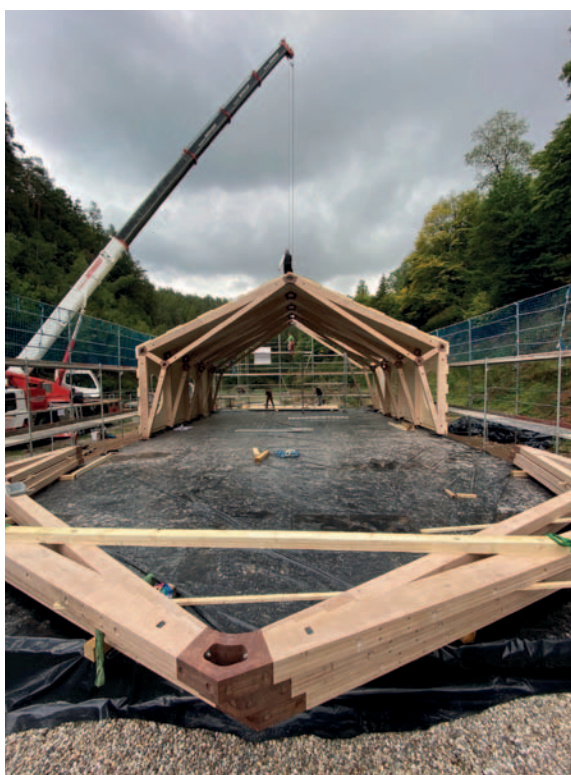
▲ Die Dreigelenkrahmen werden gestellt ...
