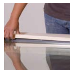
Einclipsen der Glasleiste
