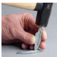
Sperrlaschen gegen- gleich ausbiegen (optional)
