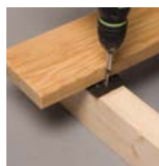
Verschrauben Lagerholz
