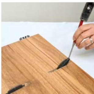
Verbinder flächenbündig mit Einschlagwerkzeug einschlagen.
