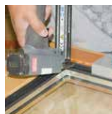
FIXclip-Schiene verschrauben oder nageln
