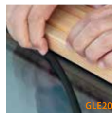
Keildichtung einpressen
