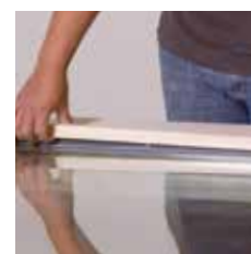
Einclipsen der Glasleiste
