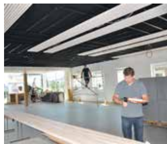
Akustikdecke im Seminarraum von Knapp GmbH | Design in Tanne weiß lasiert mit DEKLICK® Klemmverbinder montiert.
