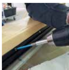
FIXclip-Schiene verschrauben
