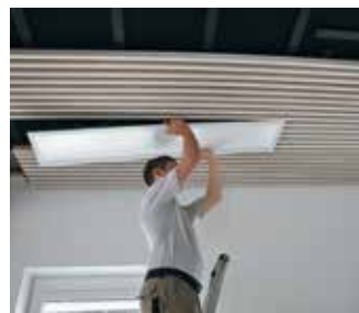
Akustikdecke im Seminarraum von Knapp GmbH | Design in Tanne weiß lasiert mit DEKLICK® Klemmverbinder montiert.
