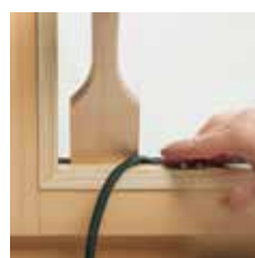
Keildichtung einpressen
