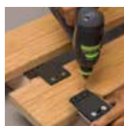
Vorbohren mit Schablone
