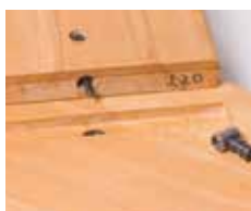
Spannelement in Bohrungen einlegen
