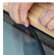
Keildichtung einpressen
