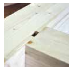
Gesicherte Verbindung durch Sperrbügel
