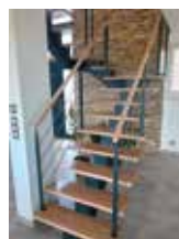
Aufgesattelte Stufen mit Acro befestigt
