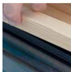
Einclippen der Glasleiste
