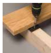
Verschrauben Lagerholz
