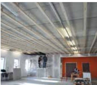
Akustikdecke im Seminarraum von Knapp GmbH | Design in Tanne weiß lasiert mit DEKLICK® Klemmverbinder montiert.
