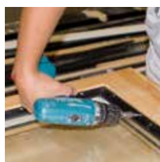
FIXclip-Schiene verschrauben oder nageln
