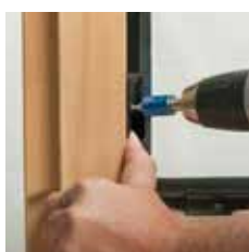
FIXclip GLE20 schräg verschrauben
