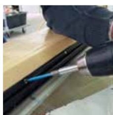
FIXclip-Schiene verschrauben
