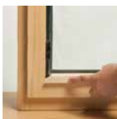
Einclippen der Glasleiste
