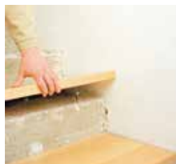
Bohrungen übertragen
