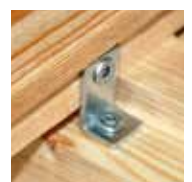
Z-DECK fertig montiert
