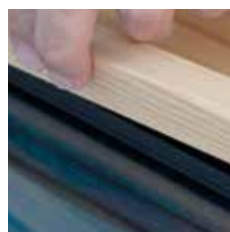
Einclippen der Glasleiste
