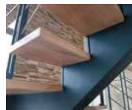
Aufgesattelte Stufen mit Acro befestigt
