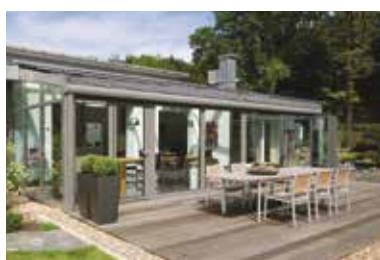
Construction de jardin d'hiver
