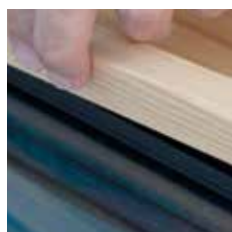
Clipser la parclose sur FIXclip-Barre
