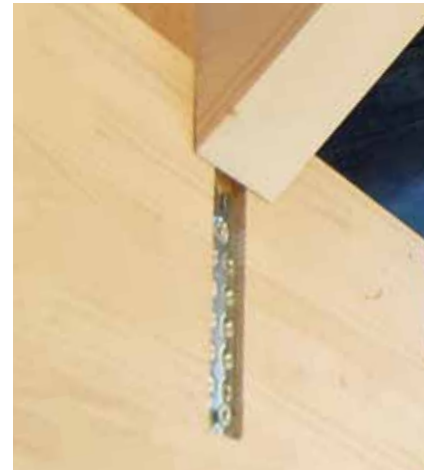
Assemblage de chevron avec RICON® 160/40.
