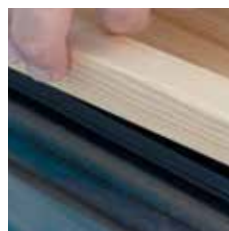
Clipser la parclose sur FIXclip-Barre
