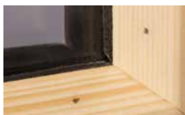
Fixation traditionnelle de parcloze par clouage.
