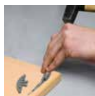
Finir le positionnement avec le chasse clou
