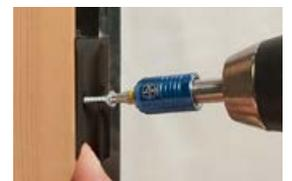
Verschraubung mit KNAPP® SK-Edelstahlschrauben 3,5x25 mm mit Bohrspitze
