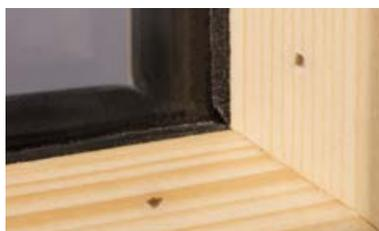
Herkömmlich befestigte Glasleiste mit sichtbaren Nägeln.
