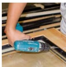
FIXclip-Schiene verschrauben oder nageln
