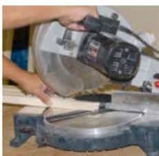
Glasleiste und FIXclip-Schiene zuschneiden
