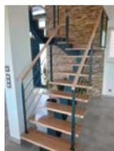
Aufgesattelte Stufen mit Acro befestigt
