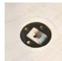
Die Sperre einsetzen um die Verbindung zu sichern
