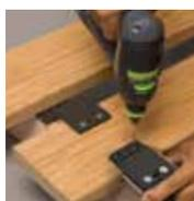
Positionner et pré-percer avec le gabarit
