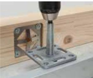
Gewindestangen in Beton einsetzen und den WALCO® 80 M16 verschweißt aufschrauben.
