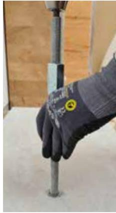
Die Gewindestange im Beton befestigen.
