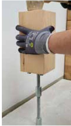
Die Stütze auf nivellierte Grundplatte WALCO® 80 M16 verschweißt aufsetzen.
