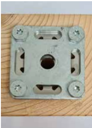
Pré-perçage et montage de la platine RUKZUCK® avec WALCO® 80 en bout de poteau.
