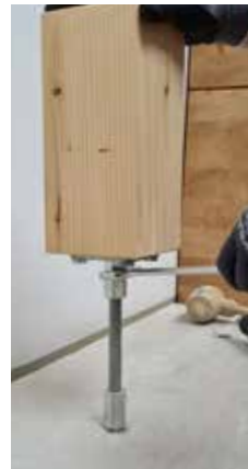
Réglage de la hauteur à l'aide de l'écrou.
