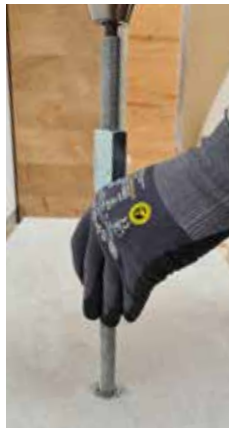
Fixation de la tige filetée dans le béton.
