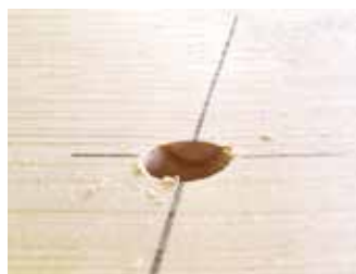
Perçage traversant de la lisse basse.
