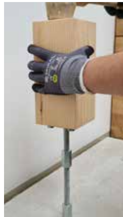
Emboîtement du poteau sur la tige filetée.
