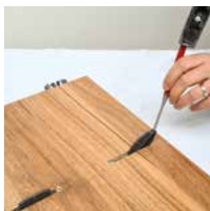
Insérer les assembleurs à fleur avec le panneau.
