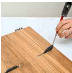
Verbinder flächenbündig mit Einschlagwerkzeug einschlagen.
