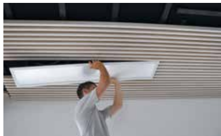
Akustikdecke im Seminarraum von Knapp GmbH | Design in Tanne weiß lasiert mit Klemmverbinder DEKLICK® und Unterzug mit MEGANT® Verbinder.
