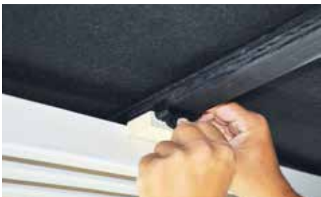
Akustikdecke im Seminarraum von Knapp GmbH | Design in Tanne weiß lasiert mit Klemmverbinder DEKLICK® und Unterzug mit MEGANT® Verbinder.
