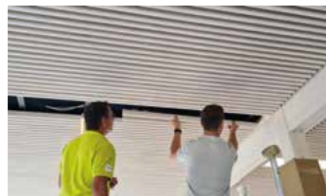
Akustikdecke im Seminarraum von Knapp GmbH | Design in Tanne weiß lasiert mit Klemmverbinder DEKLICK® und Unterzug mit MEGANT® Verbinder.
