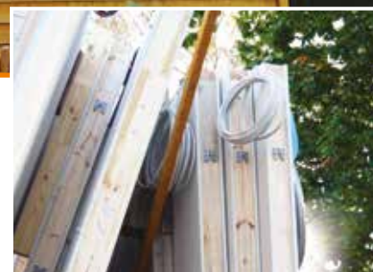
Exemple de montage : WALCO® V - Murs ossature bois fermés.
