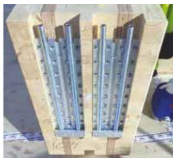
Montage encastré sur 3 côtés avec usinage en bout de panne et fixation de la plaque principale en applique sur le porteur.
