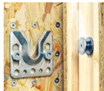
Exemple de mise en œuvre : fixation directe, en applique de la ferrure WALCO® V oblong sur panneau OSB.
