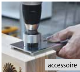
Mise en œuvre manuelle avec les gabarits KNAPP®.
