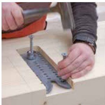
Positionnement des ferrures et vis
