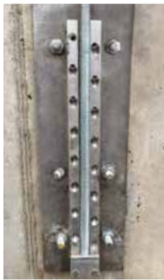
Assemblage MEGANT® sur support béton.
