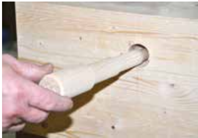
Insérer le clou jusqu'à la tête.
