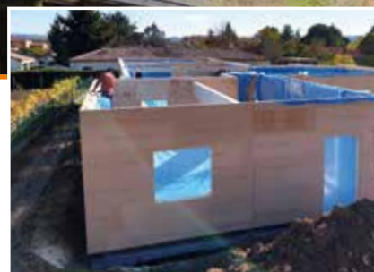
Exemple de montage : WALCO L sur ossature bois.
