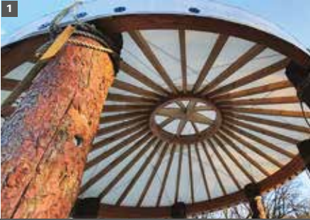
Assemblages biai de chevrons vissés sur un dôme avec T-JOINT.
