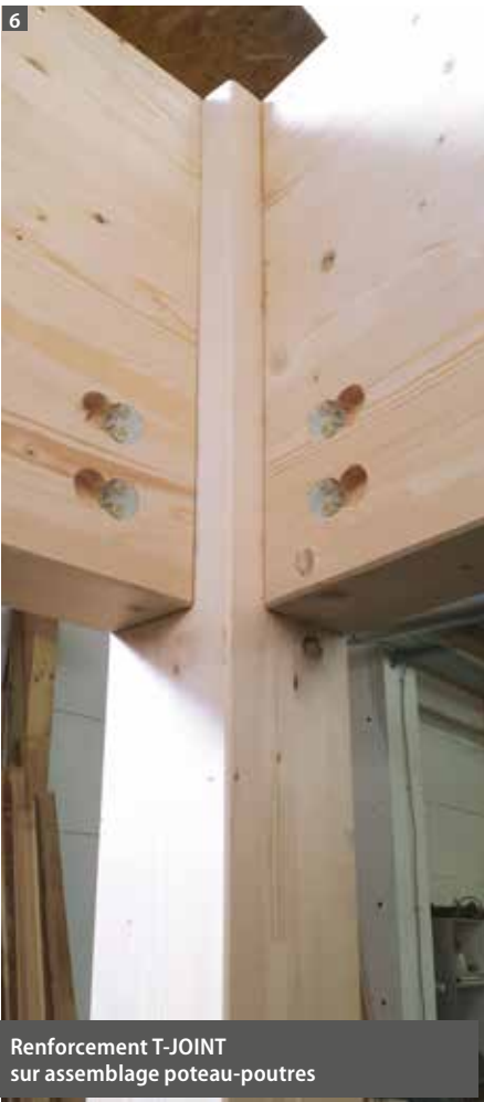
Jonctions de faitage, chevrons-poutres principales, rigides à la flexion avec T-Joint D40/W30.
