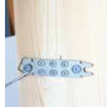
Montage de la goupille de verrouillage
