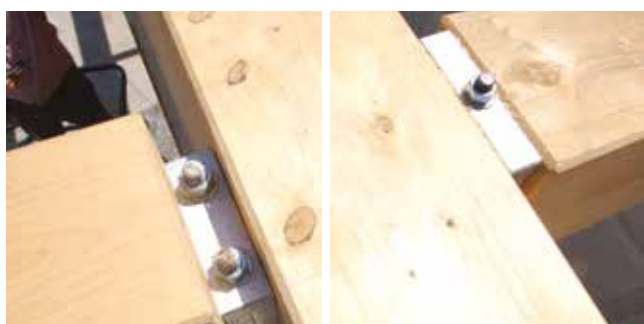
Assemblage poutres principales et secondaires en face à face avec MEGANT® en applique.
