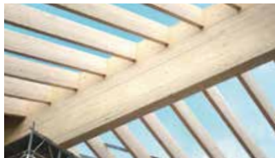
Toiture de hall avec assemblage sur panne faîtière avec RICON® S
