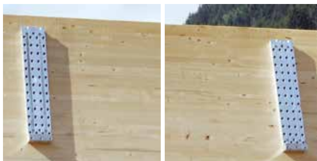
Montage avec emboîtement dans réservation en béton : distance d'accroche seulement 2 cm (sur côté opposé à la poutre principale bois)
