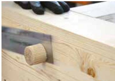
Couper et poncer la partie en dépassement.
