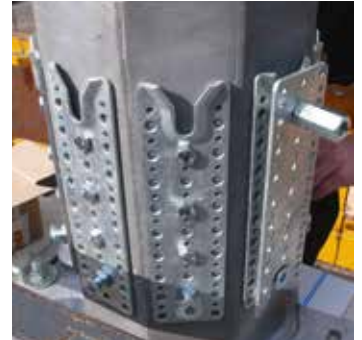
Nœud d'assemblage pour dôme
