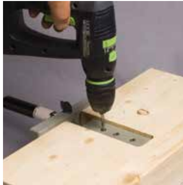
Pré-perçage poutre principale
